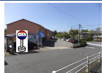
⑰ジョイントセンター前 センターの入口 あたりでお待ち ください。
